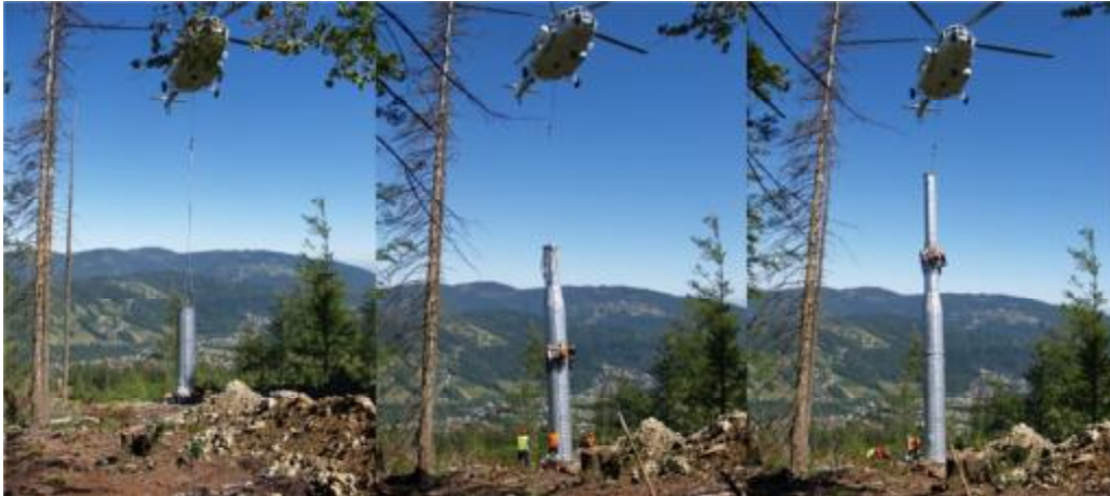
Obr. 3: Postupná montáž rúrového drieku podpory z jednotlivých dielov (autori)
