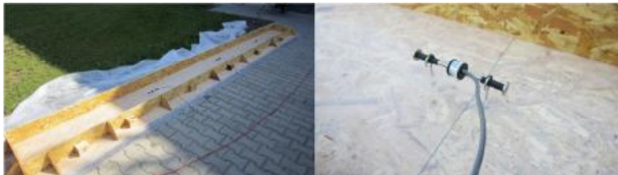
Obr. 1 Bednění a osazení vnitřních strunových tenzometrů
