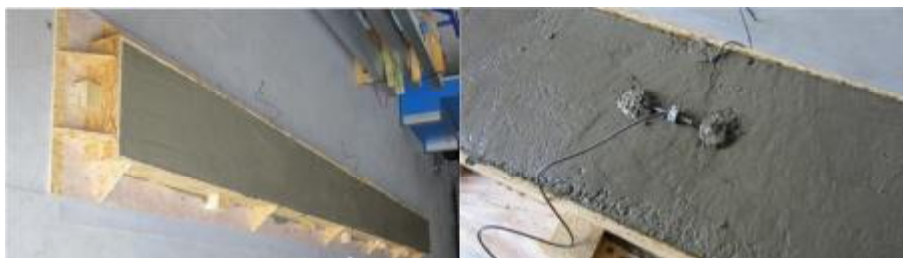
Obr. 2 Uložení betonu a osazení vnějších tenzometrů
