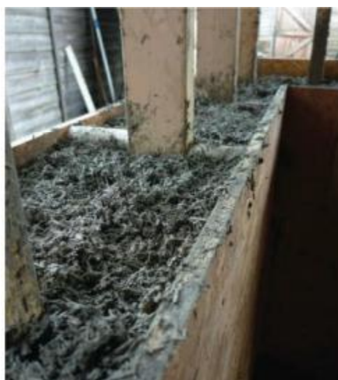
Obr. 4 Ukladanie konopného betónu do debnenia [5]
