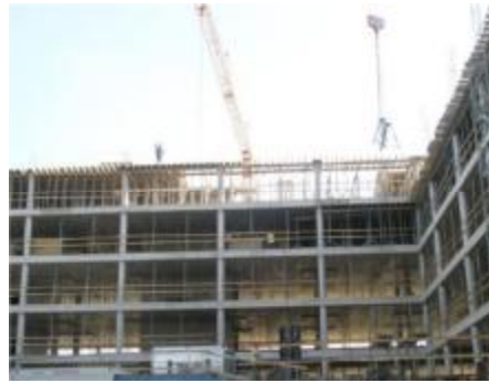
Obr. 1 Hrubá stavba sledované administrativní budovy
