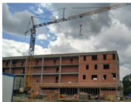
Obr. 2 Hrubá stavba sledovaného bytového domu
