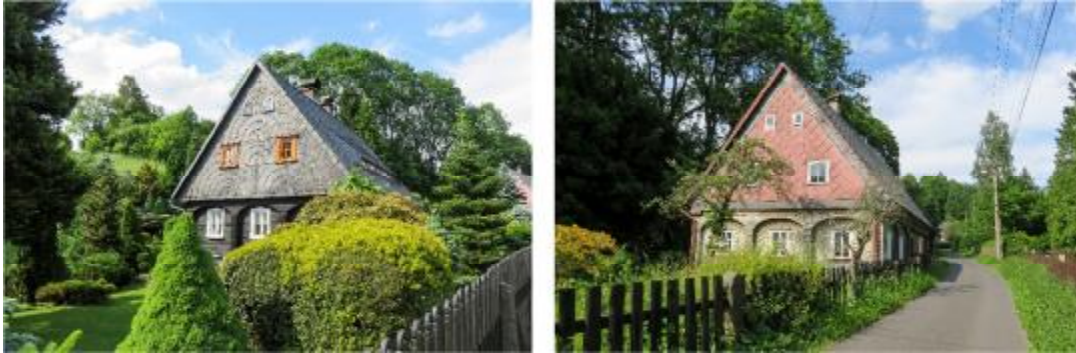
Obr. 7 Vlevo: Brtníky č.ev.27; Brtníky č.ev. 28
