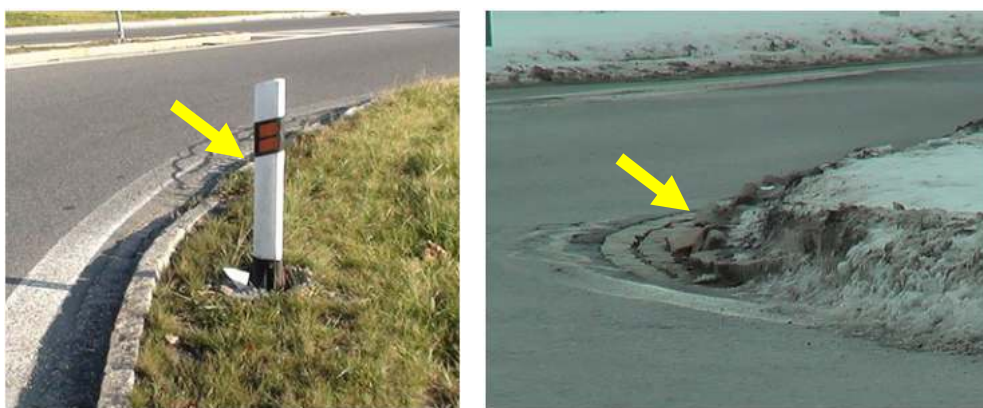
Obr. 6 Srovnání letního a zimního záběru na výjezd z okružní křižovatky; šipkou je označené stejné místo (z jiného úhlu) – vpravo již ovšem s chybným směrovým sloupkem [8]
