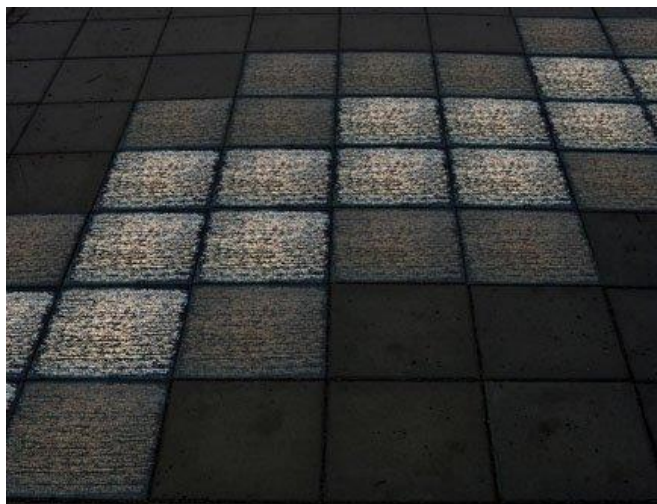
Obr. 1 Realizace exteriérové dlažby z Litraconu [5]
