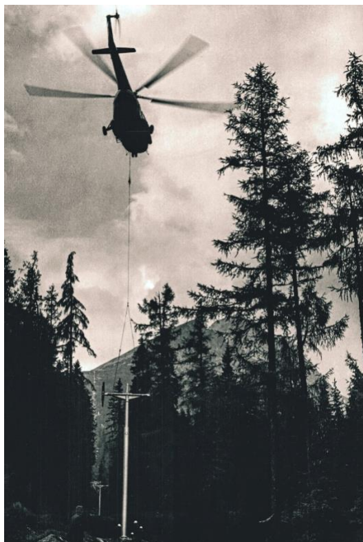
Obr. 4 Montáž podpier sedačkovej lanovky Štrbské Pleso – Solisko (Miroslav Holub)
